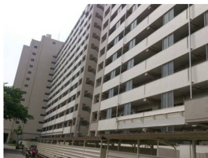
建物外観（共用廊下側）
